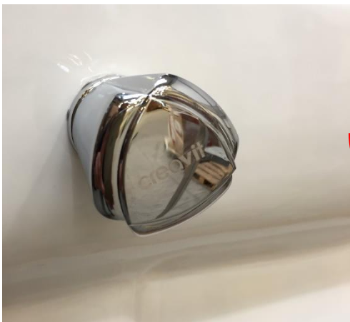
DETAIL INTEGROVANÉHO VENTILU
